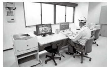
中央監視制御室
