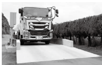
トラックスケール
