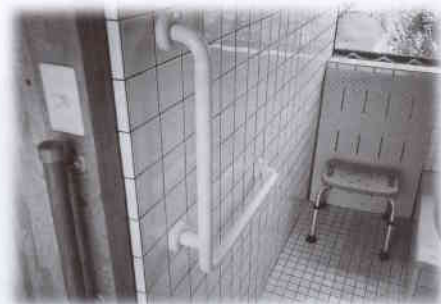
住宅改修と福祉用具購入の例
